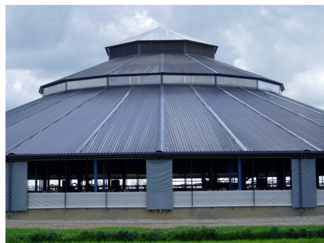
42 DS Stålkonstruktion projekterede og leverede betonelementer, stålspær og trapezplader. Taget er profilerede stålblader med en kondensisolering bestående af en mineraluld og en plast membran.
