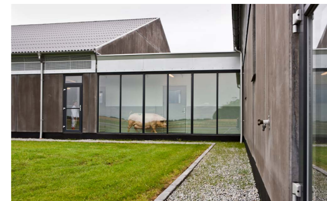
Ind- og udsyn til og fra staldene via transparent forbindelsesgang i glas.
