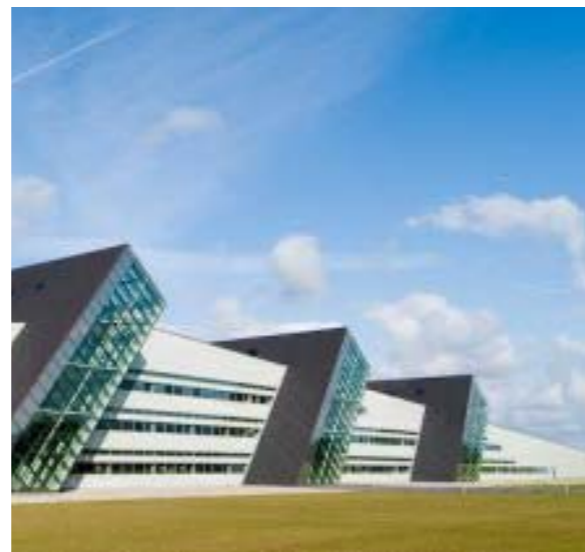
Fiberline Composites domicil i Middelfart. Facaden på Fiberlines 300 meter lange fabrik kombinerer fordelene ved glas og komposit, og det resulterer i store spænd af glas med næsten usynlige samlinger.
