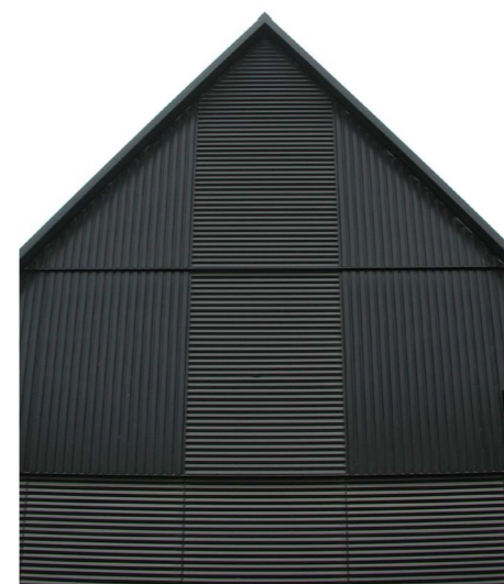
Til denne udvidelse af et korn tørringsanlæg er stålpladernes profilering brugt som detaljering i bygningens facade. En diskret og rolig måde at skabe variation i facaden uden, at den fremstår urolige.
