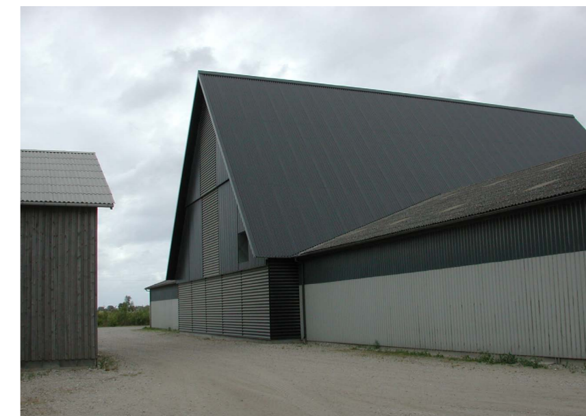
Anlæggets højeste bygning der er holdt helt i mørkegråt, er en tilføjelse til en eksisterende bygning, der ligeledes er beklædt med stålplader. Tilføjelsen med den markante, stejle tagflade har givet anlægget et stærkt udtryk.
