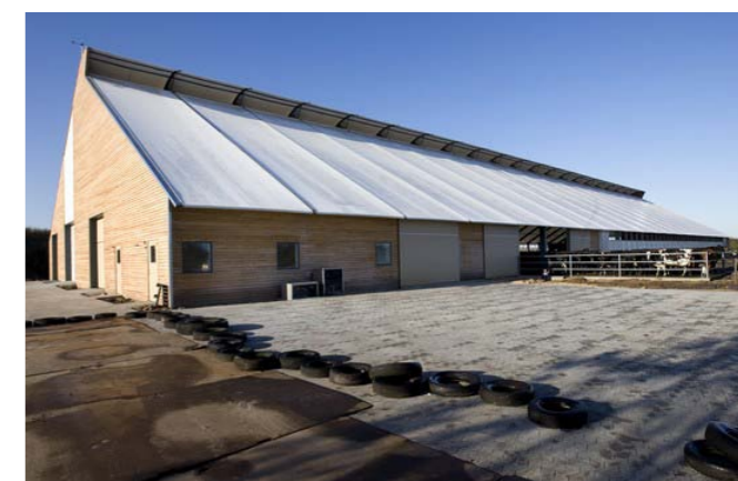
Denne økologiske malkekvægsstald har facadebeklædning i ubehandlet cedertræ, bærende konstruktioner af mørkt malet stål og tag af hvidt armeret PVC-folie. Bygningen virker let og elegant, dens udtryk er minimalistisk og nutidig, men samtidig imødekommende pga. af valget af træ i facaden, der er monterede på klink og det translucente tag, der bevirker, at stalden er lys i dagtimerne.
