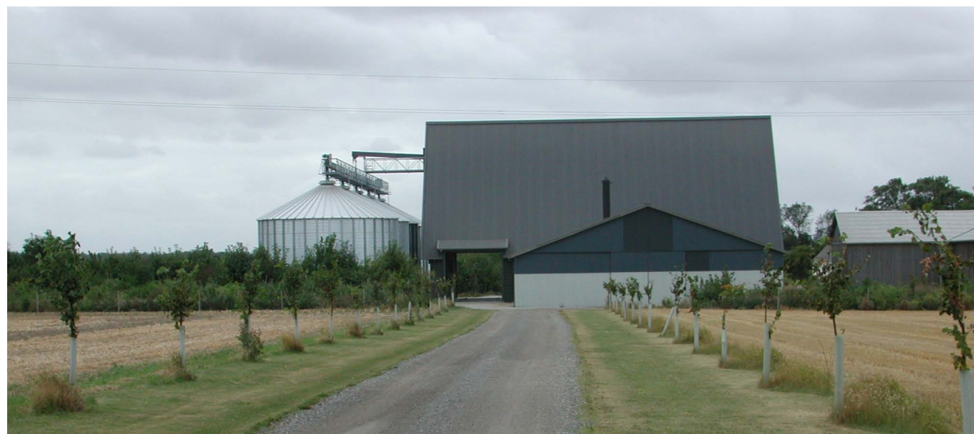
Stålplader har vundet større og større indpas som tag og facadebeklædning på de danske landbrugsbygninger. På billedet er et kornbehandlingsanlæg set i sin landskabskontekst.
