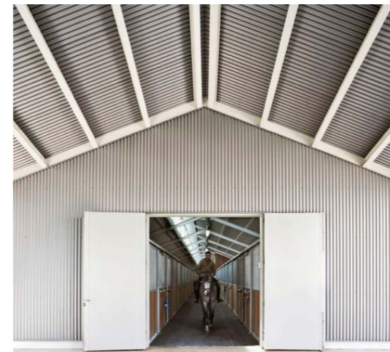
Detaljer og udnyttelse af materialernes egenskaber får bygningerne til at fremstå eksklusive og helstøbt. © P. Pegenaute
