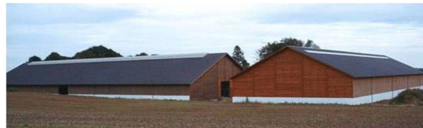
Bygningsanlæg med en facadebeklædning i træ med hvid betonsokkel og med en tagflade i fibercement. Materialernes farver stemmer fint overens med landskabets.
